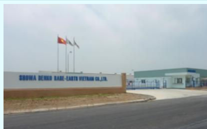
出所: 昭和電工社ホームページより
