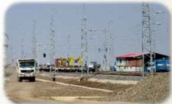
アジス-ジブチ新鉄道建設
