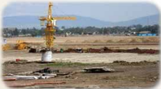
建設中のハワッサ工業団地
