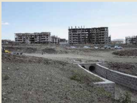
キリント工業団地の日系企業専用地区候補地の現状、隣接する高速道路、高速道路を挟んで向かいの団地建設。
